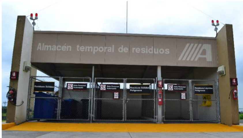
Fig 05: Almacén temporal de aeropuertos de la Red ASA, Gobierno de México
